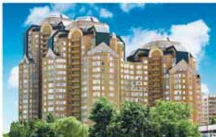
Подземные гаражи в жилом комплексе Аркада Хаус
